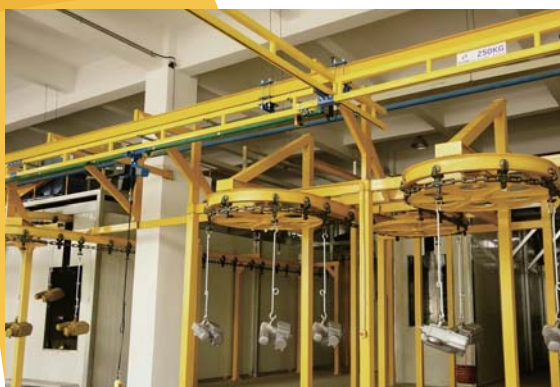
产品表面喷涂流水线
